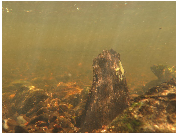
Vue d'un des pieux à section quadrangulaire
