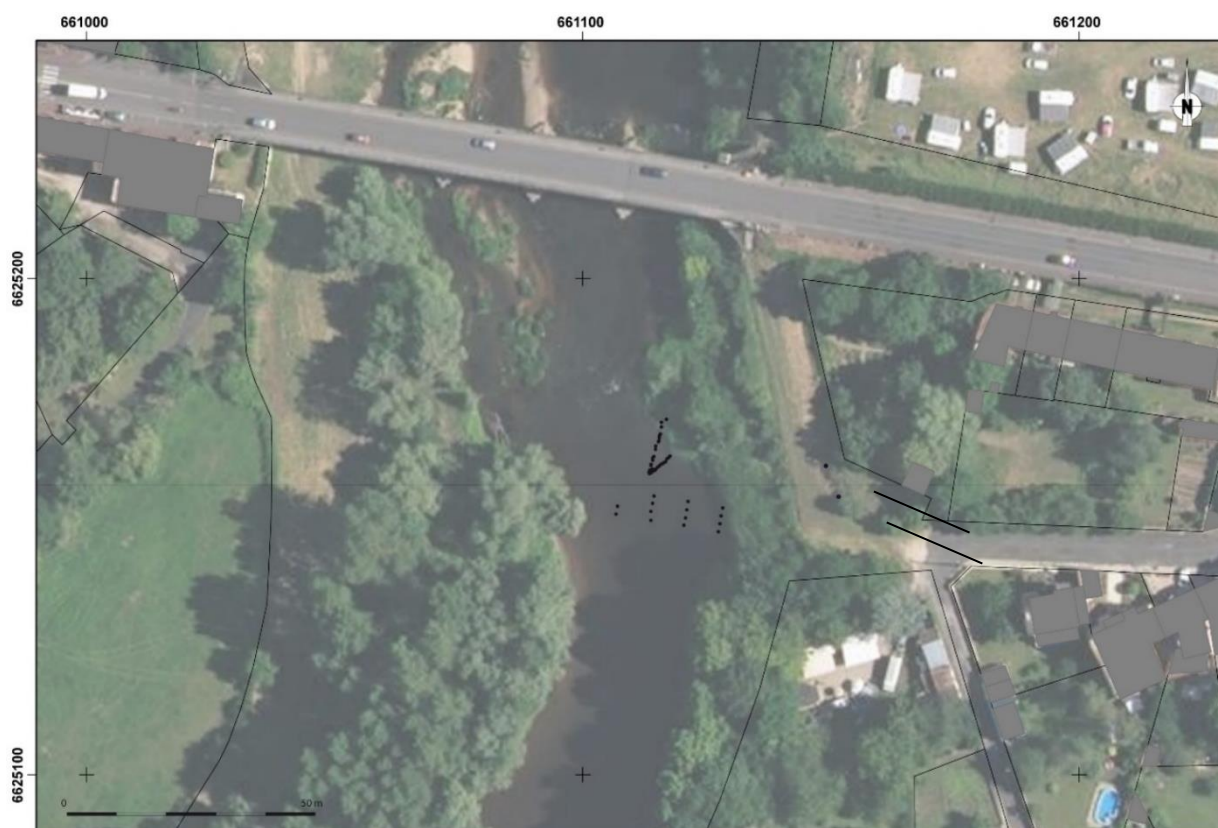
Fig.4 – Pieux en amont du pont d'Orval sur fond photo et cadastre (E. Yény)
